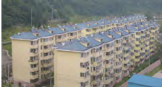
中国湖北铁山，一个新住宅区配备的太阳能热水器
